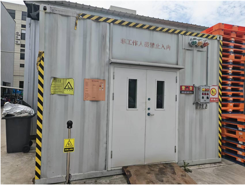
图 4-5 危险废物暂存场所
